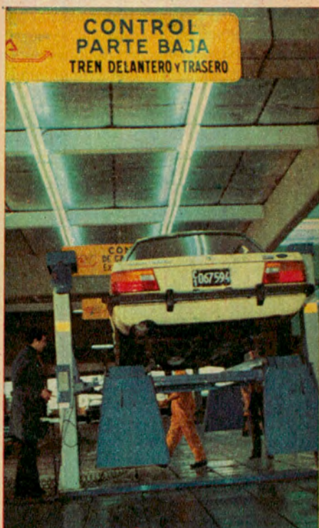
El auto ha sido levantado para el control mecánico y visual de la parte baja.
